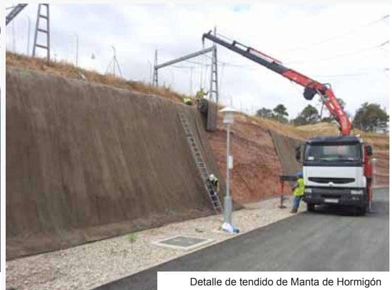
Vista General de la Instalación de Manta de Hormigón
