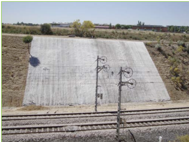
Vista general del talud reparado
