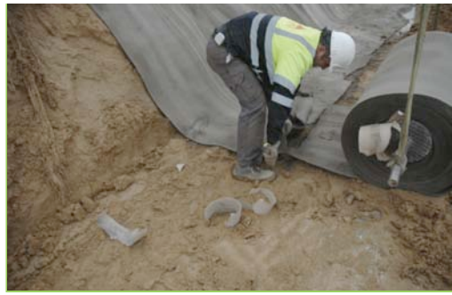
Detalle del corte de la Manta de hormigón
