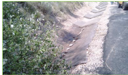
Ejecución de cuneta con la Manta de Hormigón frente a la ejecución de cuneta tradicional
