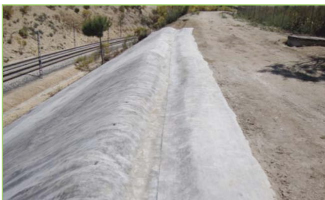
Cuneta de guarda en cabeza del talud reparado
