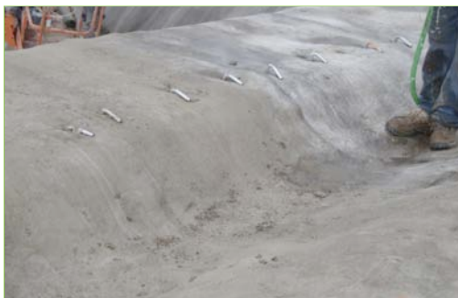
Detalle de anclaje al terreno
